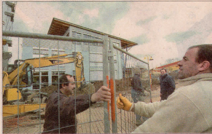
Die Zäune werden aufgebaut, die Baustelle eingerichtet. Im Sommer soll der Anbau fertig sein. ■ Foto: Rüdiger Mosler
